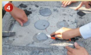
4 解体後は浸透性剥離剤(ボンドリムーバー・リムーバーZ)を使用するとより効果的に接着剤部分の取り除きができます。
